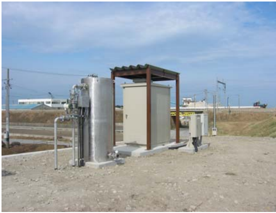
図-10 下黒部橋設置水循環式SMDP と局舎
