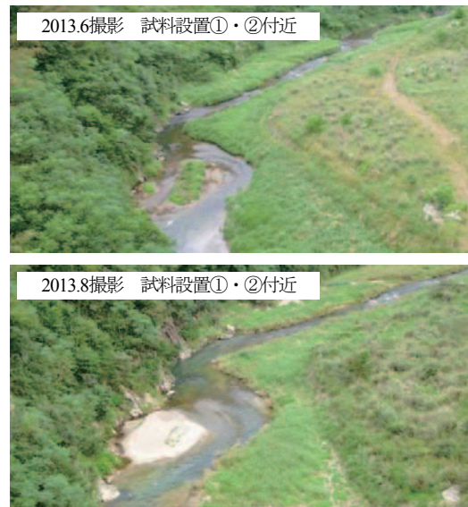
写真-2 益田川ダム貯水池堆積状況の変化
