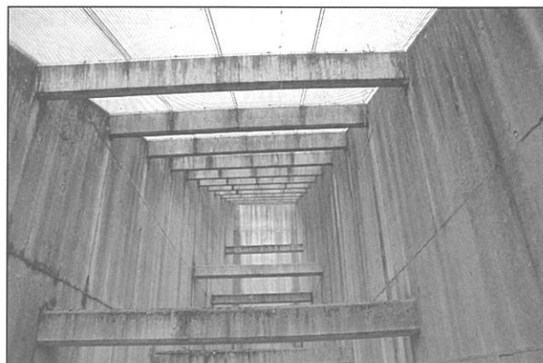
写真-28 河床部放流設備上部の開口部 (Stullneggbach)
