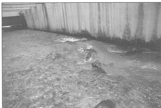
写真-25 河床部放流設備内の石張り (Lafnitz-Waldbach)
