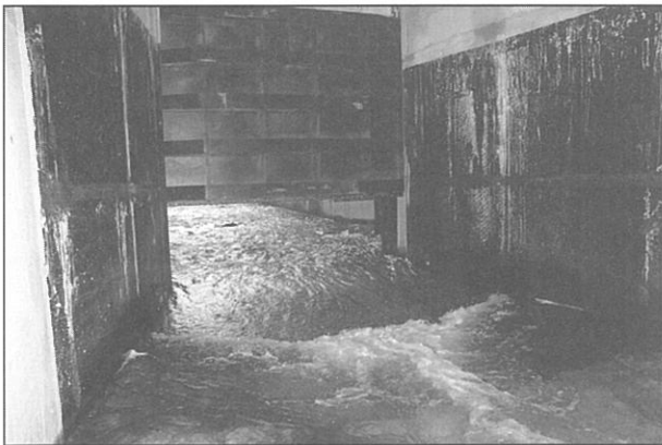
写真-5 鋼製ゲート (Lafnitz-Waldbach)
