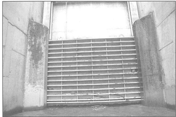
写真-6 鋼製ゲート (Stullneggbach)
