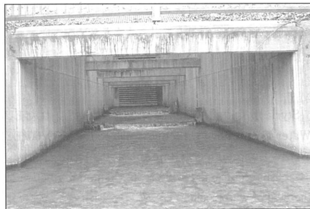
写真-26 河床部放流設備の堰き上げ (Stullneggbach)
