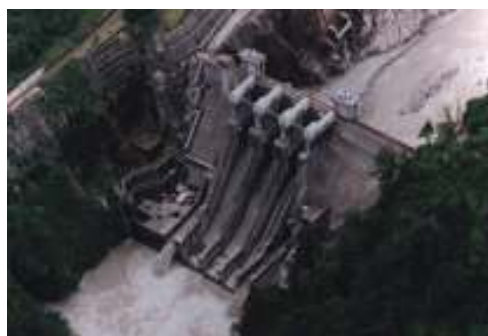
Dashidaira dam Barrage de Dashidaira
