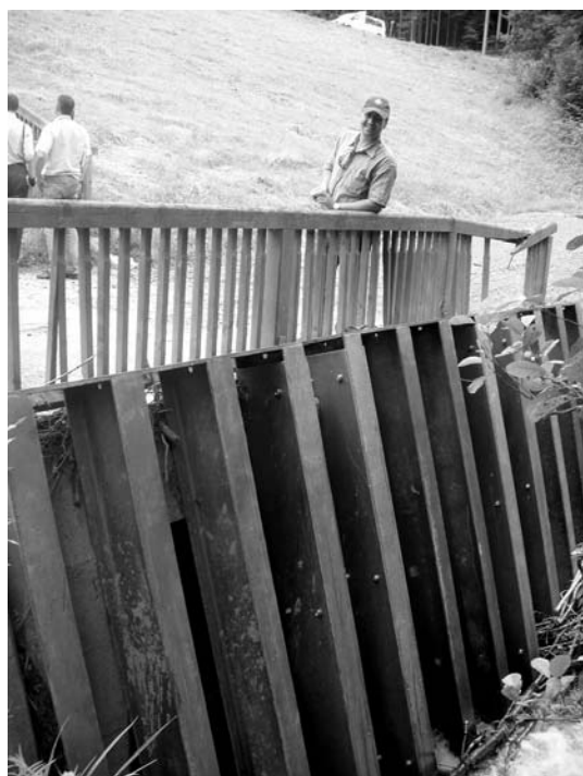
写真ー 15 底部洪水吐き前面のスクリーン
