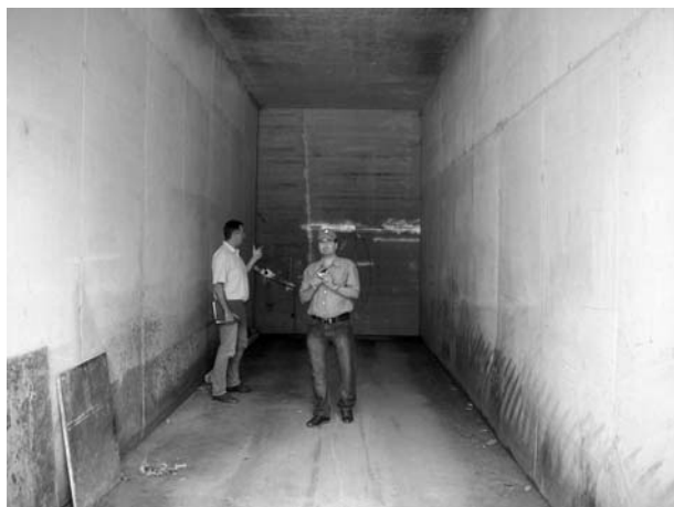
写真-13 管理用通路の内部（下流側：奥が管理用通路の扉）
