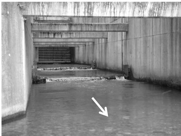
写真－18 ステップ水路状の底部洪水吐き内部（ダム下流側）
