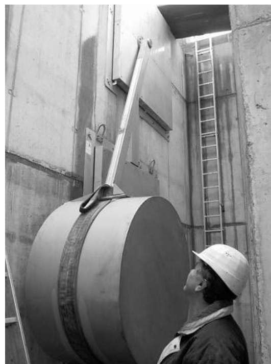
写真-8 底部洪水吐きの自動開閉ゲート
