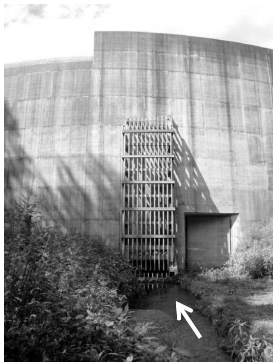
写真-11 ダム上流面（底部洪水吐きとスクリーン）
