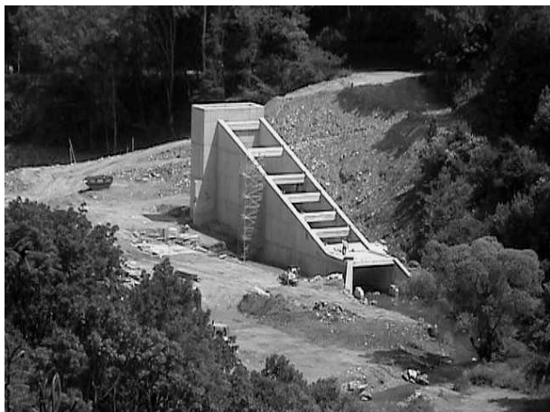
写真－22 複合ダムの底部洪水吐き部の施工状況 (Lafnitz/Waldbach)
