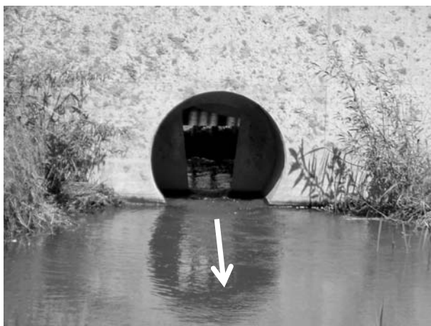
写真-4 底部洪水吐きのゲート部 （金属プレートで絞り込んでいる）
