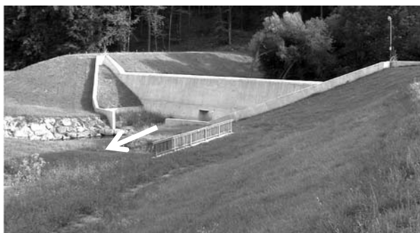
写真-25 洪水吐き部（ダム下流面）
