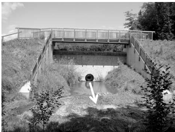
写真-3 底部洪水吐きと越流部洪水吐き（下流側より）
