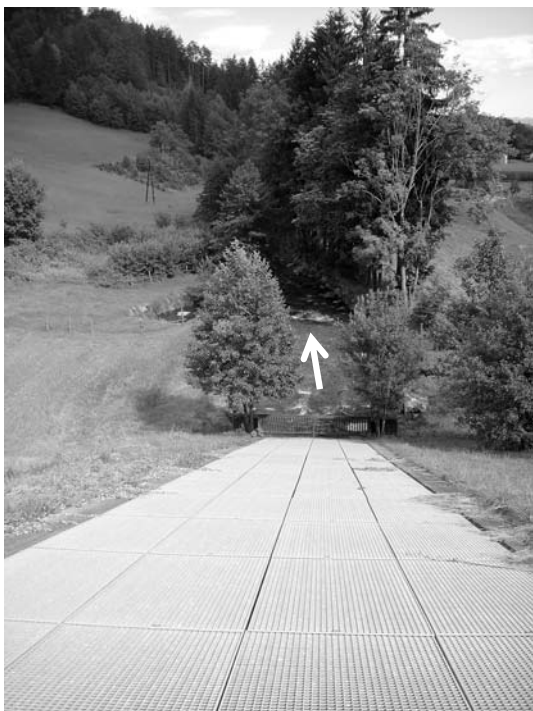
写真－20 底部洪水吐きの開口部とグレーチング
