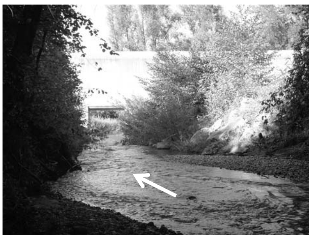
写真-26 底部洪水吐き（ダム上流面）
