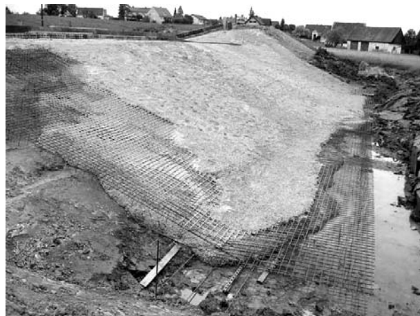
写真－23 非常用洪水吐き部の施工状況
