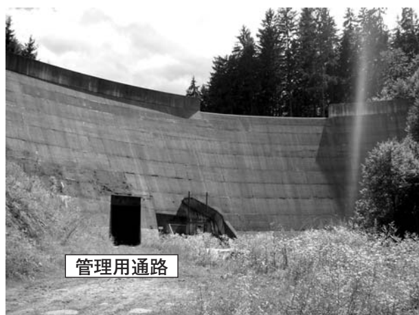
写真-12 ダム下流面（左側の開口部が管理用通路）
