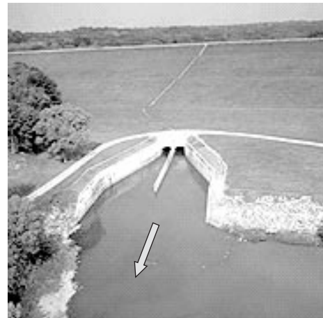
写真-8 洪水吐き (平常時) (Englewood ダム)
