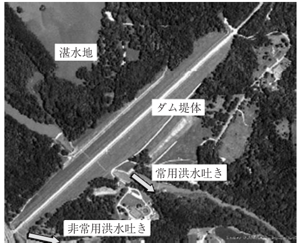
写真-7 Englewood ダム (1921 年完成)
