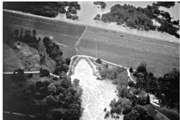
写真-9 洪水吐き (洪水時) (Englewood ダム)
