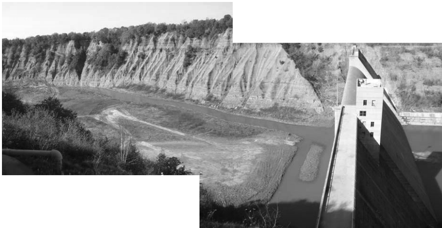
写真-12 貯水池内の状況 (Mount Morris ダム)
