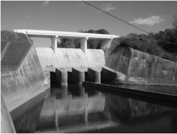
写真-4 洪水吐き (Taylorsville ダム)
