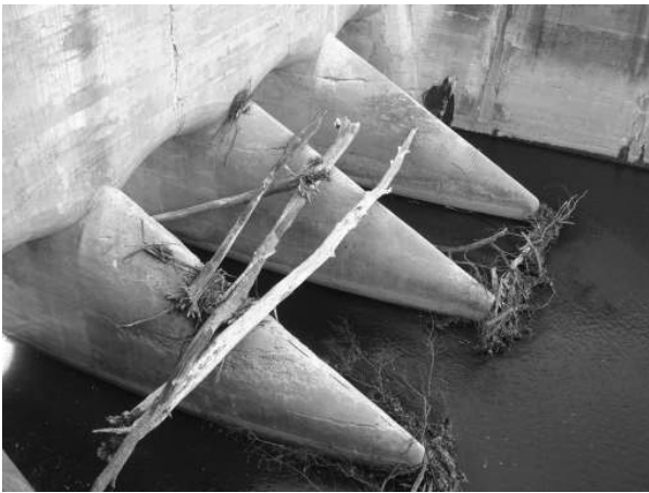
写真-5 洪水吐き上流側 (Taylorsville ダム)
