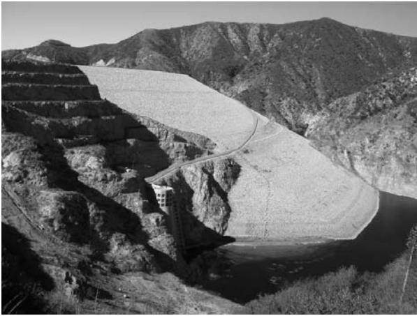
写真-17 貯水池内の状況 (Seven Oaks ダム)
