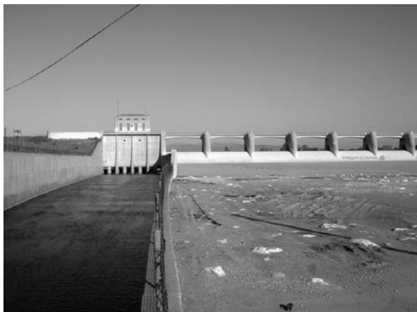
写真-20 Sepulveda ダム洪水吐き (左：常用，右：非常用（ドラムゲート付))
