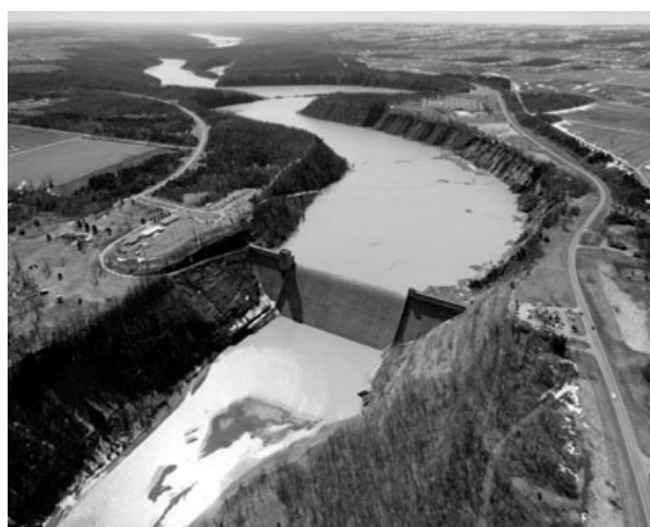
写真－11 洪水時の状況（Mount Morris ダム）
