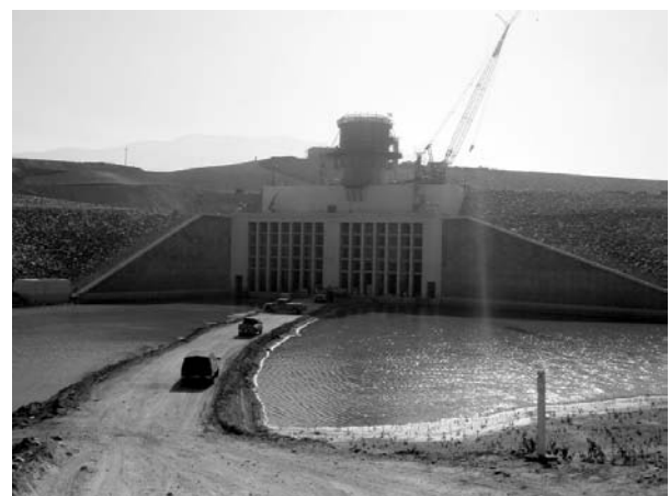
写真-15 新設常用洪水吐き流入部
