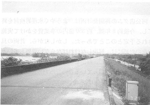
写真-8 阿公店ダム堤体
