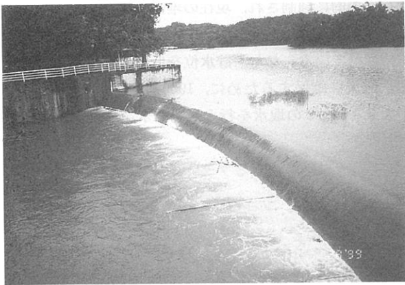
写真-6 尖山埤ダム洪水吐き (排砂トンネル流入部は左側木立の向こう側)
