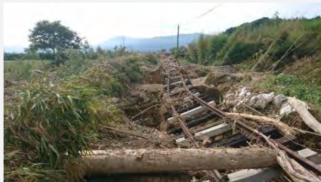
⑧落橋したくま川鉄道「球磨川第四橋梁」(川辺川合流直下流)
