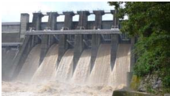
相模川水系城山ダム
