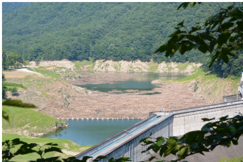
ダムでの流木の捕捉状況（7月18日撮影）
