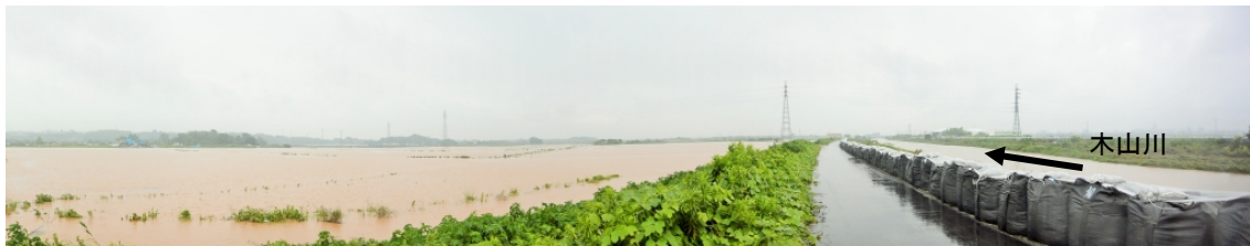
写真-10: 木山川左岸側、九州自動車道下流の浸水状況。益城町島田地区。6月21日17時30分頃撮影。
