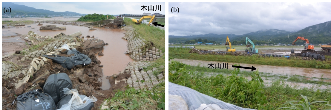
写真-3: 木山川左岸の堤防決壊状況。益城町赤井。赤井川との合流地点のすぐ下流、五楽橋直上流地点。 (a) 左岸上流側より 6 月 21 日撮影、(b) 右岸より 6 月 22 日撮影。
