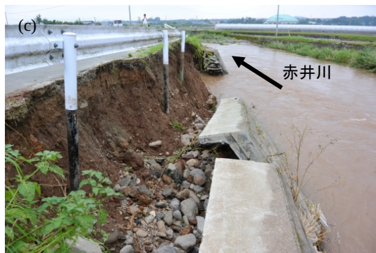
写真-8: 赤井川左岸堤防の浸食状況。益城町赤井地区。6月21日15時頃に撮影。
