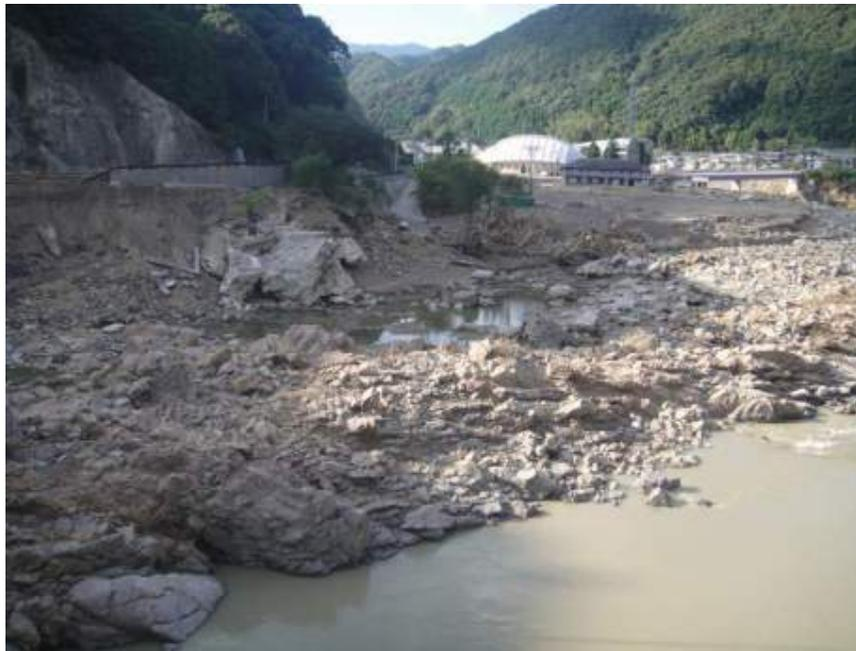
河床砂州の砂利が流出し大きく岩盤化
