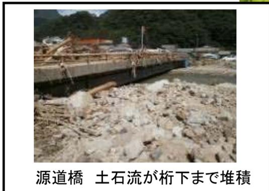
源道橋 土石流が桁下まで堆積
